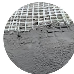
Malte composte di calce idraulica naturale ad elevata resistenza meccanica (Classe M15) specifiche per il rinforzo strutturale di murature in pietra, mattoni o tufo sottoposte al restauro: intonaci armati (CRM) o rasature armate (FRCM) con le reti della linea GLASSNET, BASALNET o SECUREGRID, iniezioni consolidanti con malte ad elevata resistenza a compressione.
