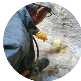
Malte specifiche per il risanamento di murature poste in ambienti particolarmente umidi o comunque soggetti a fenomeni di risalita capillare: intonaci deumidificanti, iniezioni per la realizzazione di barriere chimiche antirisalita, prodotti sigillanti e impermeabilizzanti.
