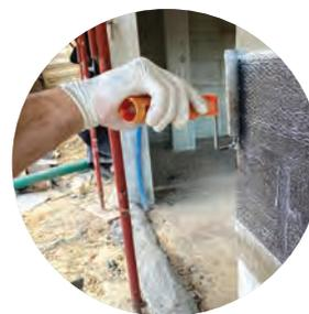
Gamma di reti e tessuti o nastro in tessuti resistenti in filato di carbonio ad alta tenacità (HT) o alto modulo (HM), vetro, basalto, aramide o acciaio da impregnare in situ mediante matrici epossidiche o inorganiche per il rinforzo strutturale con sistemi compositi FRP.
