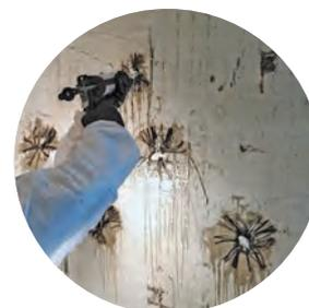
Corde in fibre di carbonio, vetro, aramide o basalto unidirezionali ad alta resistenza da impregnare in situ per l'ancoraggio dei sistemi FRP agli elementi strutturali da rinforzare, connettori preformati ad "L" per intonaci armati (CRM), barre elicoidali in acciaio per cuciture di lesioni murarie e per l'ancoraggio strutturale.
