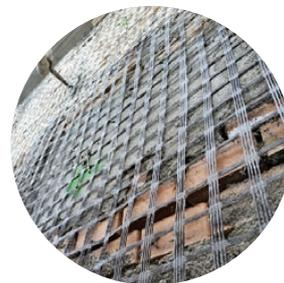
Gamma di reti resistenti in filato di Vetro o Basalto, pre-apprettate, preformate, da applicare con malte inorganiche o resine epossidiche; utilizzabili per il rinforzo strutturale di murature ed elementi strutturali in c.a, per interventi di antisfondellamento di solai e antiribaltamento di pareti in muratura.
