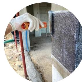
Gamma di reti e tessuti resistenti in filato di Carbonio ad alta tenacità (HT) o alto modulo (HM), vetro, basalto, aramide o acciaio da impregnare in situ mediante matrici epossidiche o inorganiche per il rinforzo strutturale con sistemi compositi FRP.
