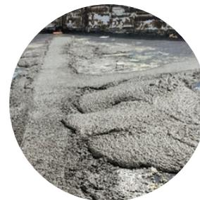
Malte strutturali e colabili ad alto contenuto di fibrorinforzo, mono e bicomponenti (polimero modificate), specifiche per intonaci armati (CRM), rasature armate, ripristino e rinforzo di elementi in C.A. e muratura.
